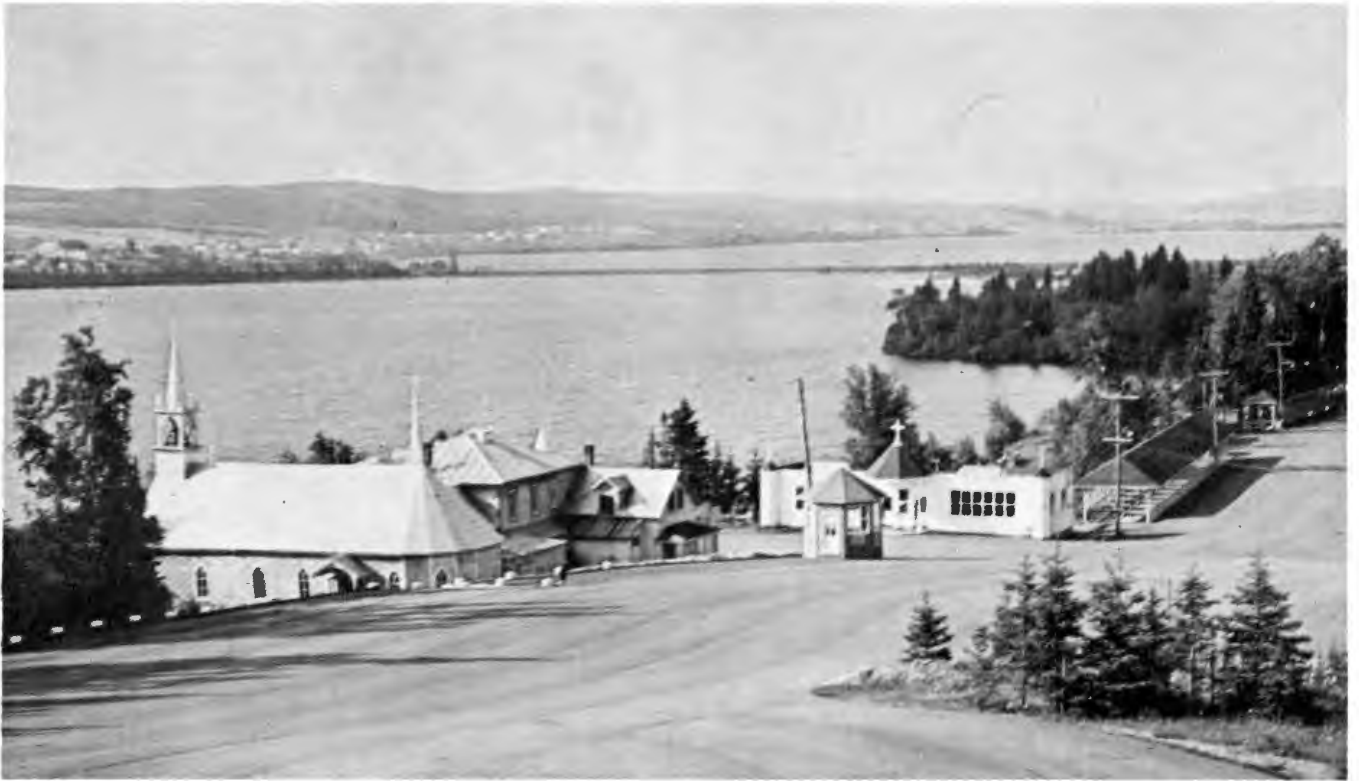
Lac-Bouchette — Vue prise de la rive opposée. Remarquer la passe qui sépare les deux lacs.
