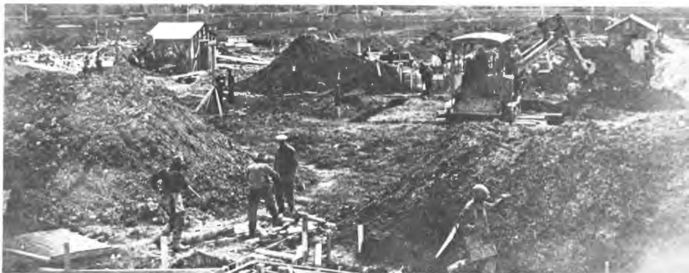
Travaux d'aménagement de l'usine Alcan Arvida 1925.
