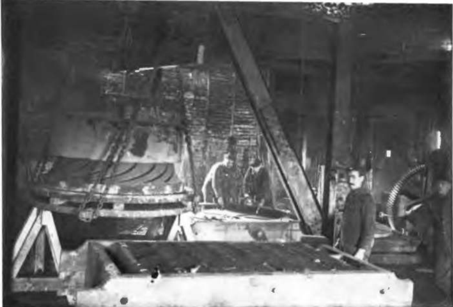
Employés travaillant à la pose de la turbine hydraulique. D'un modèle en bronze à moyen détachable, cette turbine développait une force de 1,950 chevaux sous une tête d'eau de 85 pieds.
