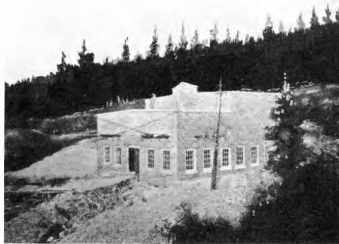
Station de transformateurs à Chicoutimi.
