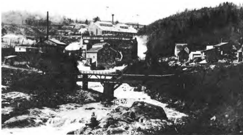
Vue générale des installations de la Compagnie de Pulpe de Chicoutimi, en particulier des pouvoirs d'eau de la rivière Chicoutimi, vers 1910.
