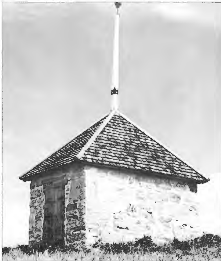
Photo Armour Landry. Coll. de la SHS aux A.N.Q.
