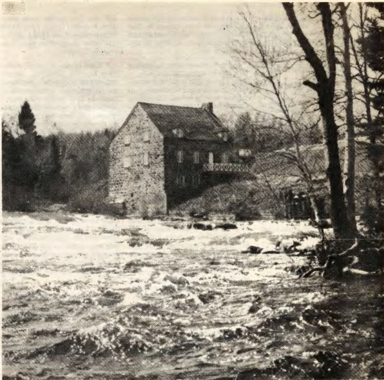
Après la restauration.
