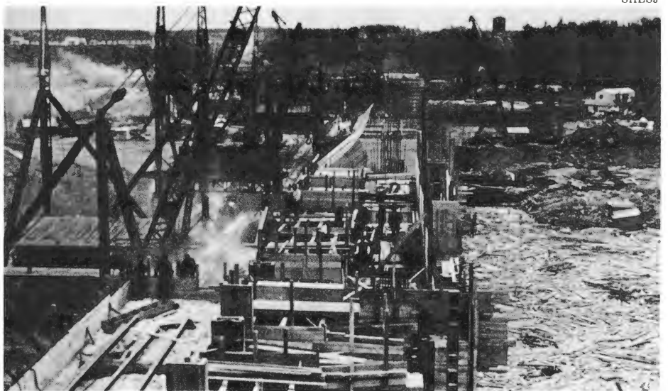
Construction de la partie inférieure de la centrale.
