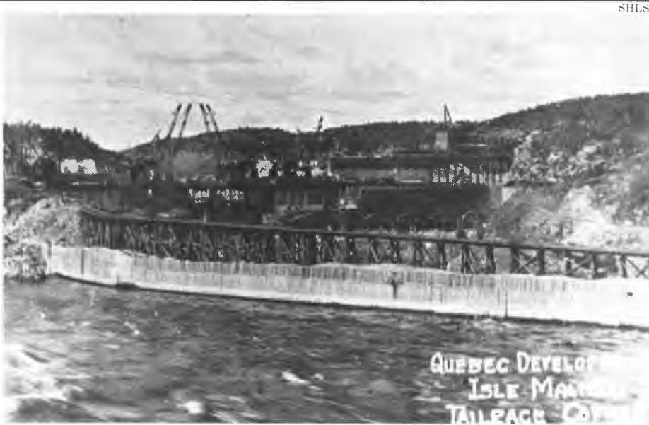
Vue du chemin de fer (servant à transporter les matériaux de construction) et du batardeau (servant à retenir l'eau). À remarquer à l'arrière-plan la centrale.
