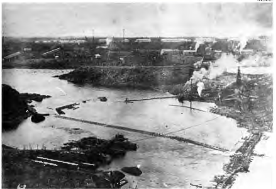
Vue de la base sur laquelle sera construite la centrale (premier plan à gauche). À remarquer à l'arrière - plan le baraquement où logeaient les ouvriers et où se trouvaient tous les services essentiels. L'ensemble donne sur le versant sud (quartier Naudville).
