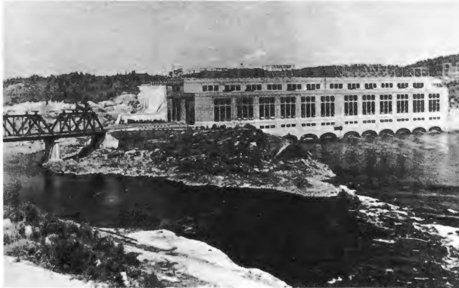
Vue de la centrale, les travaux complétés.
