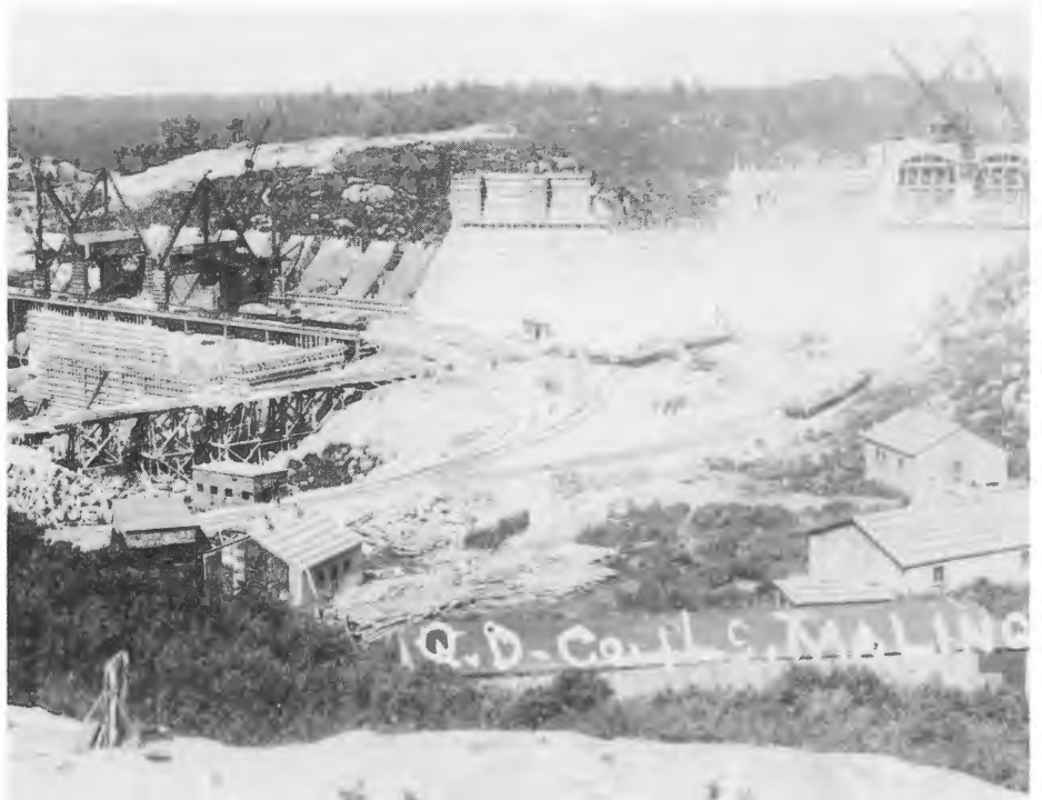
Construction de la centrale de l'Isle Maligne. Photo: Société d'Histoire du Lac-Saint-Jean.
