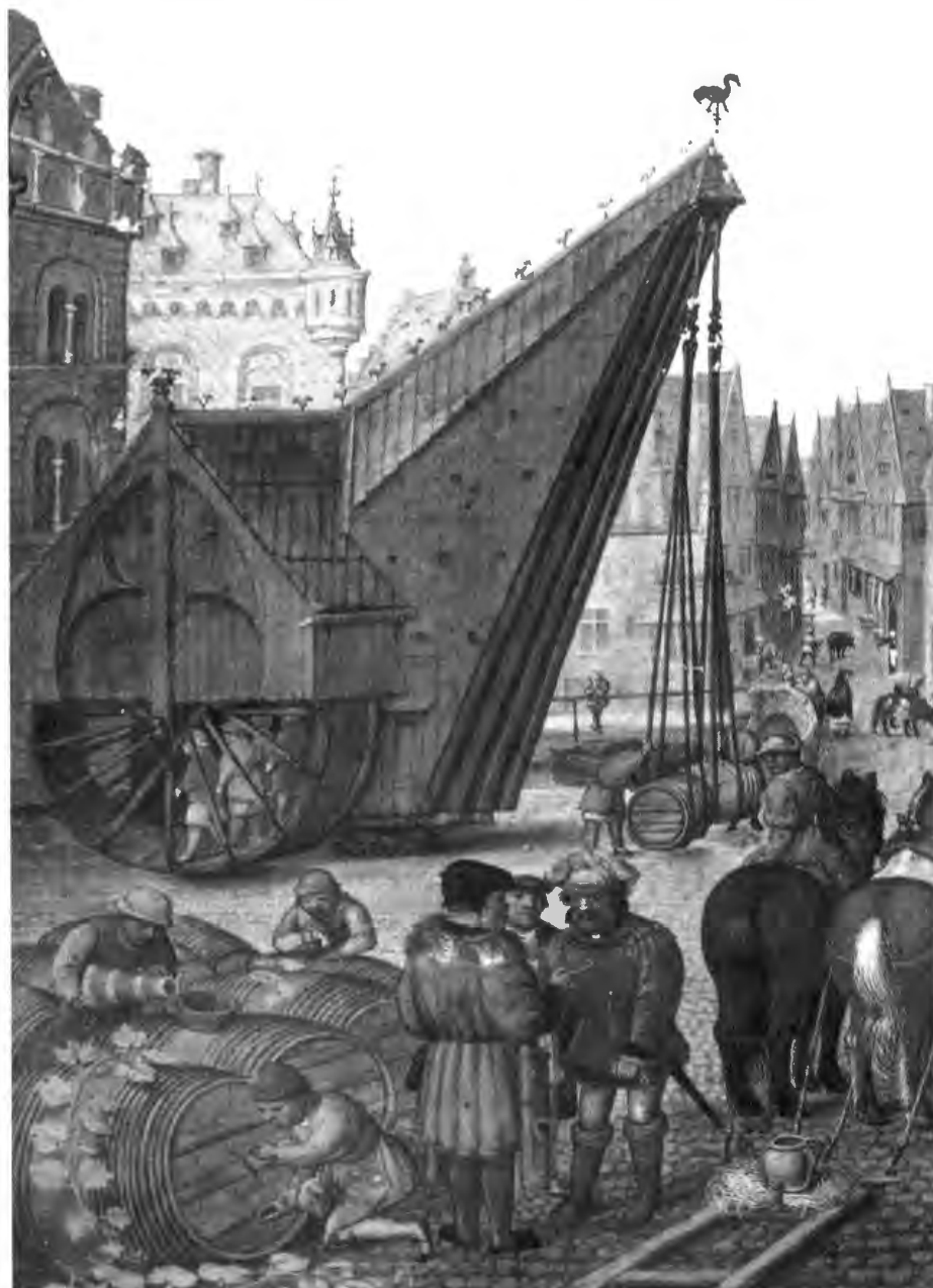
Figure 1: «Le port de Bruges. Les navires sont déchargés par un engin qui est l'ancêtre de la grue : une poulie mise en mouvement par une roue «à moteur humain» XV e siècle. Bayerische Staatsbibliothek, Munich.
