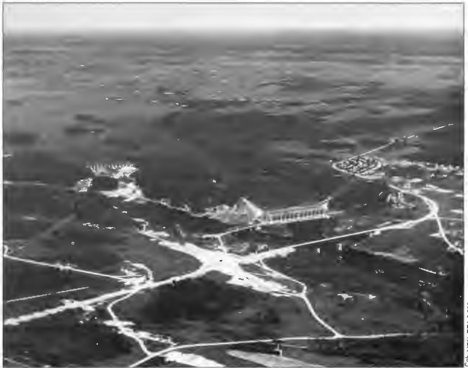
Un des éléments clés de l'infrastructure industrielle du Saguenay—Lac Saint-Jean, la centrale d'Isle-Maligne, photographiée en 1943.
