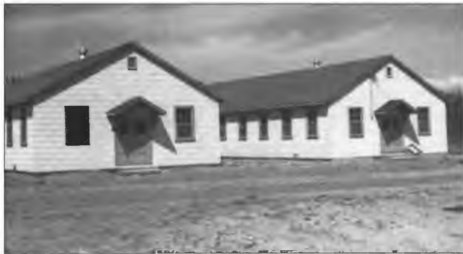
Le Mess des sergents (pilotes) le 17 juillet 1942. Cette photographie témoigne de l'avancement des travaux quelques jours avant l'ouverture officielle.
