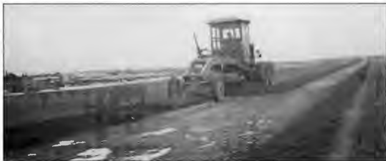
Les équipements lourds de la Local Construction à l'oeuvre pour la construction des pistes d'atterrissage.
