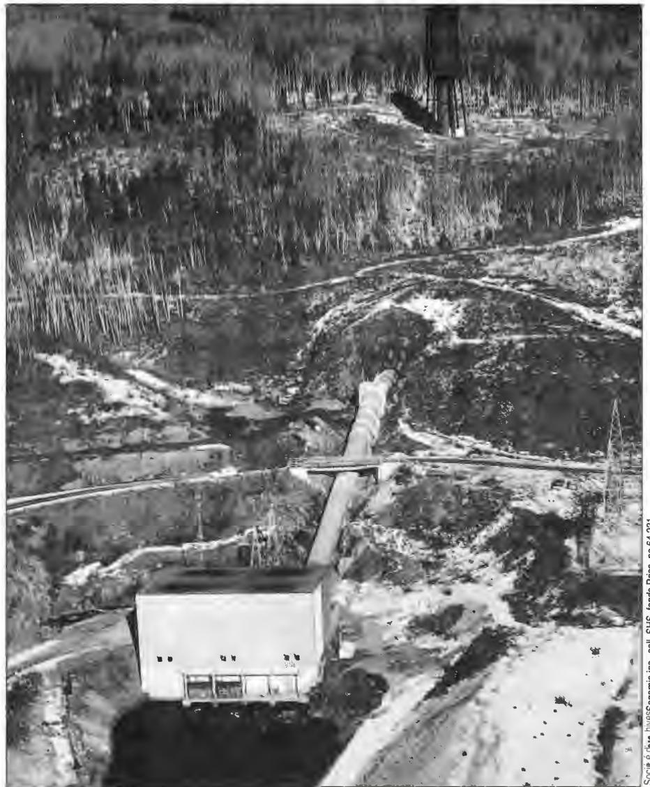
Centrale Jim Gray, au moment de sa construction. Nous apercevons la cheminée d'équilibre et la sortie du tunnel, complété par un tuyau d'acier. Le joint que nous apercevons «a dû être calculé avec certains raffinements», au dire du journal *Le Progrès du Saguenay*. Photo: 1953.
