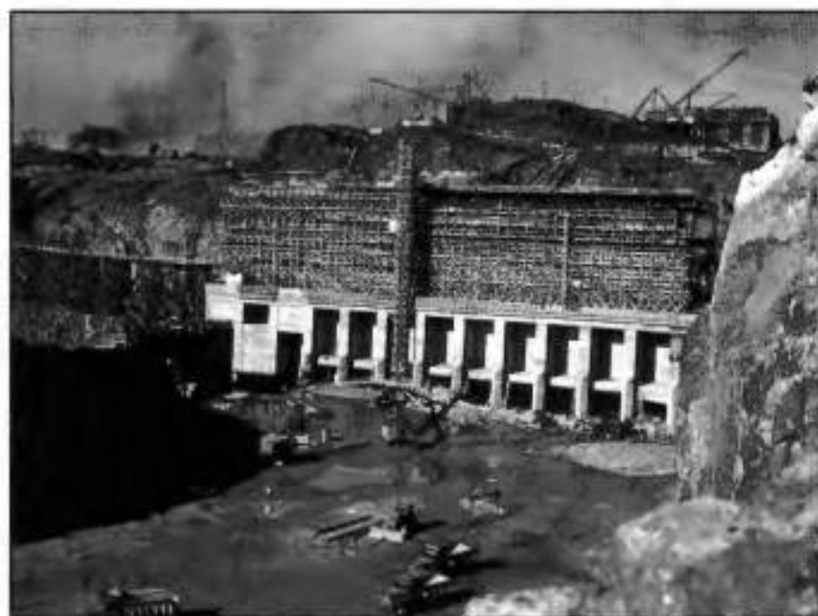
Construction de la centrale de Shipshaw en 1943.
