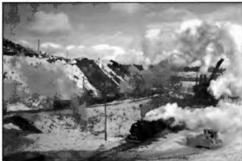
Vue du chantier de Shipshaw en 1941.
