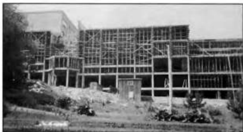
Le chantier de construction, été 1942 : la façade est, vers le jardin.
