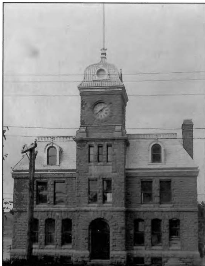
Le bureau de poste en 1905.
