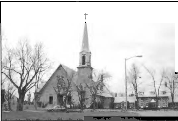
L'église Saint-Jacques, œuvre de Desgagné et Boileau (1946), inspirée des figures traditionnelles de l'architecture canadienne-française et néanmoins bien moderne, avec une structure de béton et une toiture d'aluminium.
