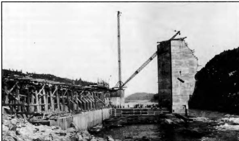
Le titan de béton quelques minutes avant son dynamitage. Ce bloc de 28 mètres et de 10 000 tonnes se renverse et bloque définitivement les eaux de la rivière le 23 juillet 1930.
