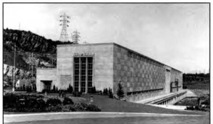
Centrale hydroélectrique Shipshaw II, œuvre de l'architecte J. C. Meadowcroft, 1941.
