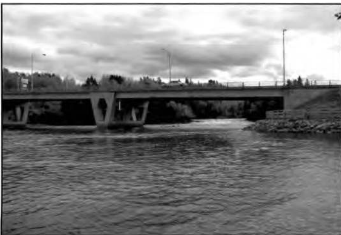
Un pont de poutres pleines en béton précontraint (plus haute résistance) remplaça le vieux pont endommagé en 1978. C'est alors que son tracé se rapprocha davantage du lac et passa de deux à quatre voies.
