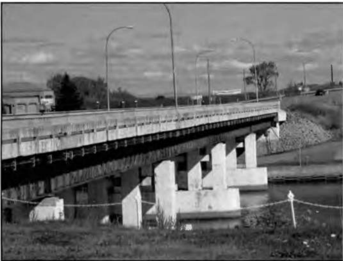
Les progrès routiers nécessitèrent une modernisation du pont sur la Métabetchouane. En 1966, un pont en béton armé à poutres pleines remplaça le pont d'acier.
