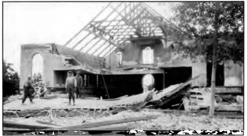
La démolition de la vieille église de bois.
