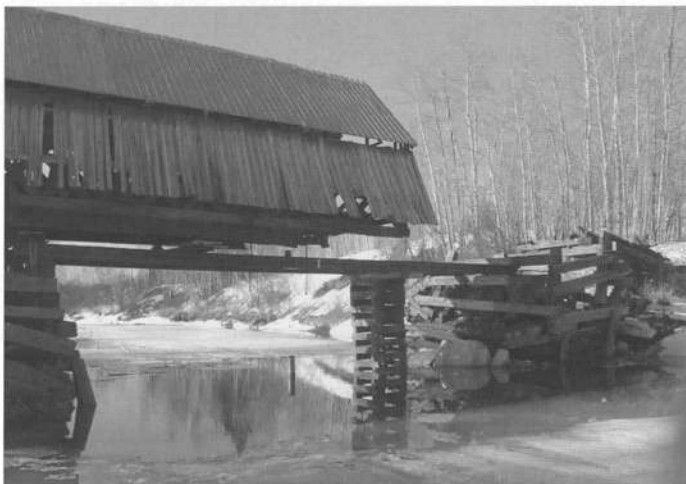
Le pont est soulevé de ses culées.
