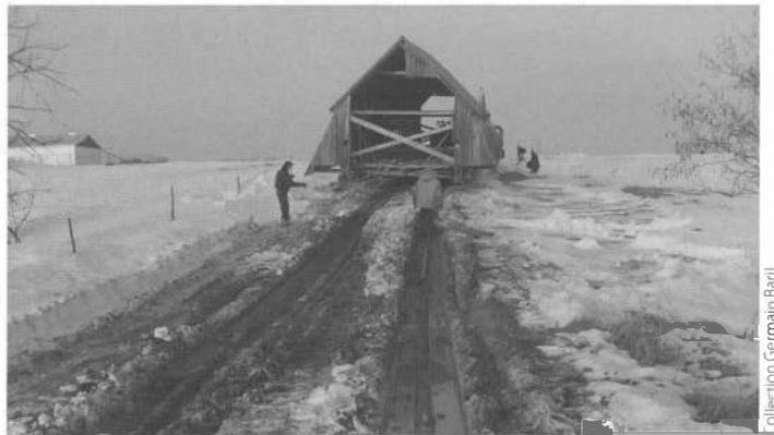
Le pont est remorqué à travers champs.
