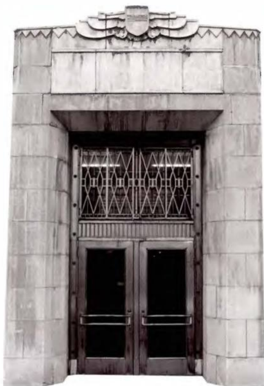
Porte en bronze de la centrale de Beauharnois datant de 1932 qui fut restaurée en même temps que la façade du bâtiment.
