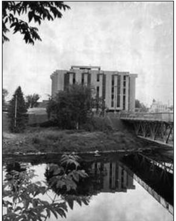
L'édifice administratif (Marguerite-Belley) de Jonquière terminé et aménagé à l'extérieur, vers 1973 SHS-FPH50-00438
