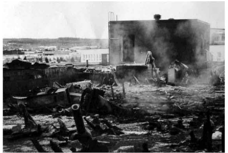
Le toit de l'Hôtel-Dieu après l'incendie.
