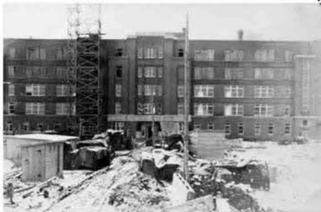
Le sanatorium en construction -1937 Source: Coll. des Augustines de Roberval
