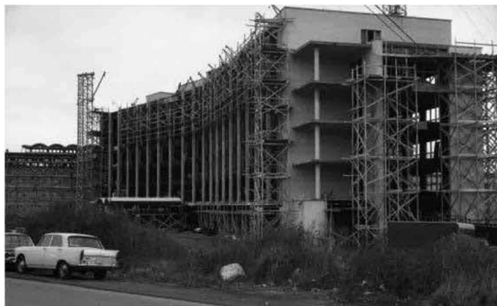
La nouvelle partie en construction en 1963.
