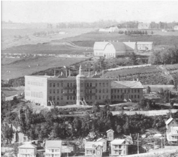
Maison Blanche adjacente au monastère, 1918. Source : Collection Archives Soeurs de Notre-Dame du Bon-Conseil.
